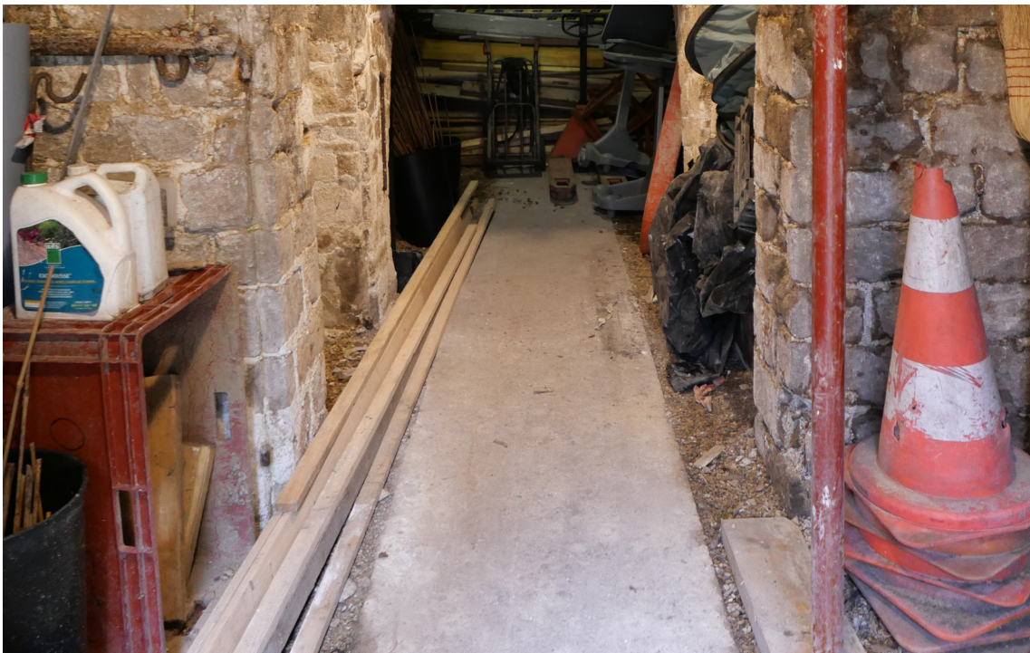
Cheminement en béton armé Source : Eugène Architectes, février 2022
