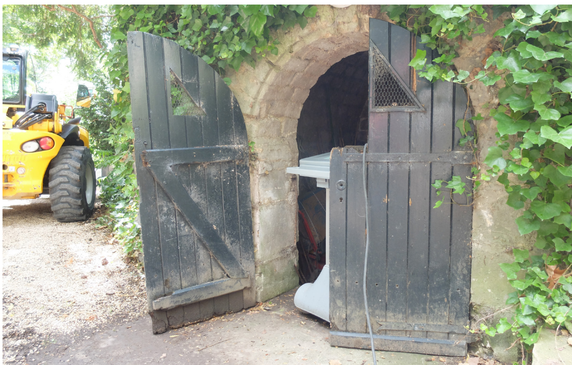
Porte d'accès à la glacière À l'état actuelle, la porte est très dégradée Source : Eugène Architectes, juin 2023
