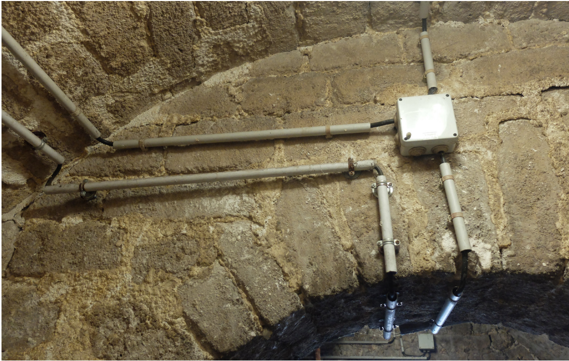
Principe de distribution électrique actuel dans la glacière Source : Eugène Architectes, juin 2023
