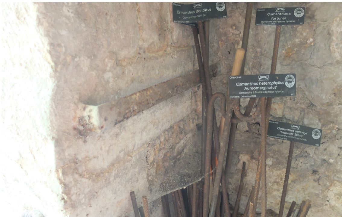
Support mural dans l'espace d'entrée D'après l'inventaire de 1811 ces plate-bandes étaient destinées à accrocher la viande Source : Eugène Architectes, juin 2023
